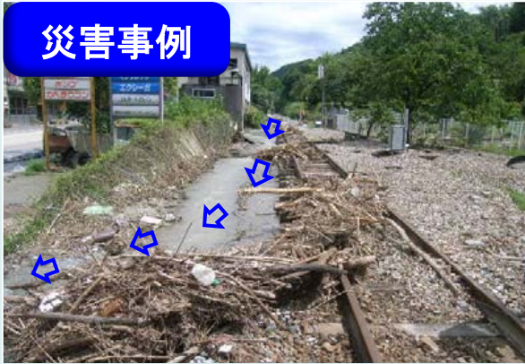
線路に流入した表面水が線路外へ流出
