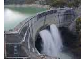
ダム放流(洪水調整) 【ダム管理事務所】
