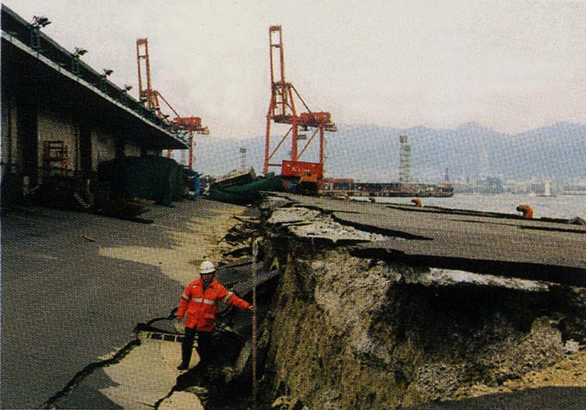
液状化により岸壁が数メートル海側へ変位、背後が2m程度沈下 (神戸港ポートアイランド、1995年兵庫県南部地震)
