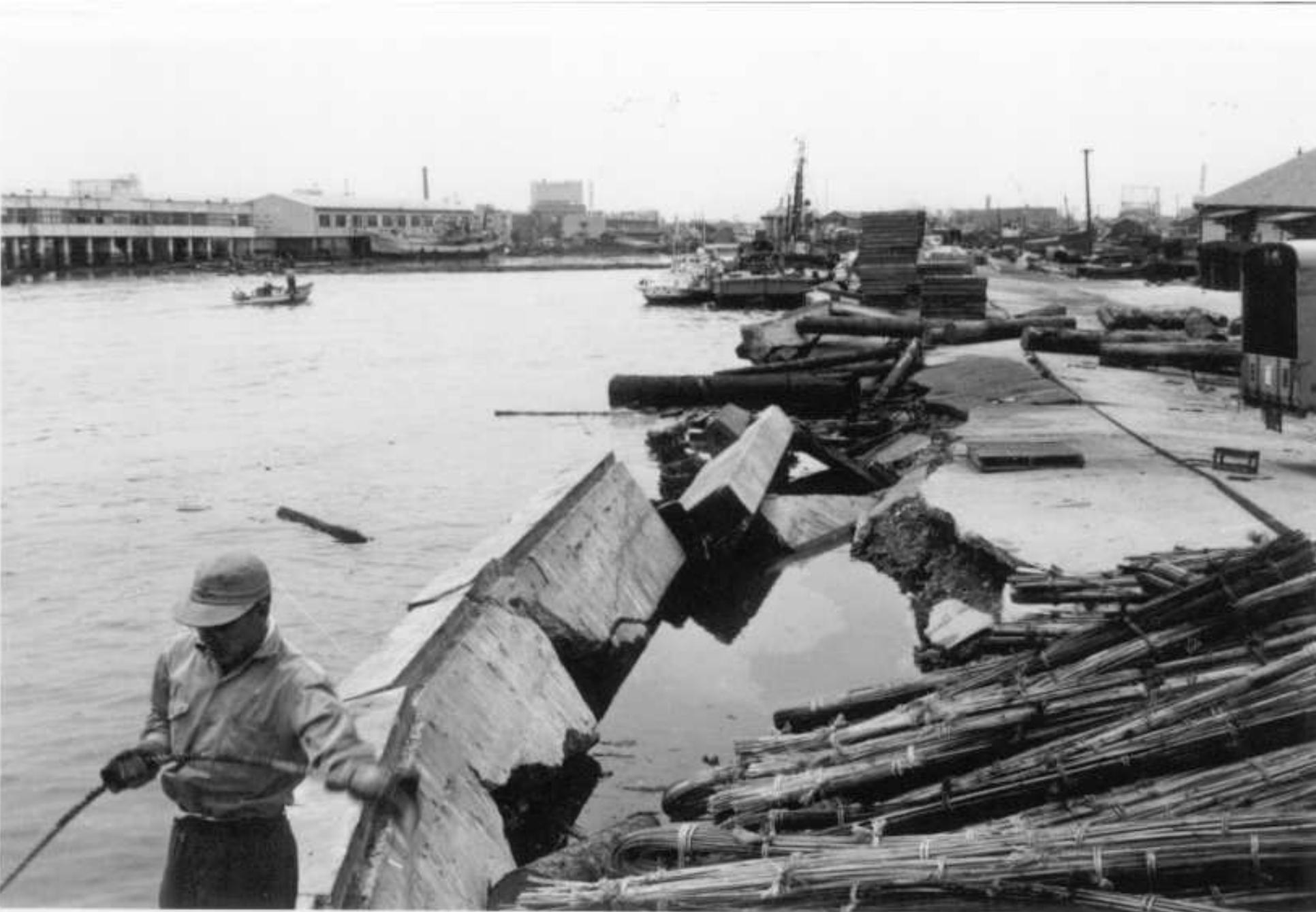
液状化による被害 万代島の船溜側物揚場 1964年新潟地震
