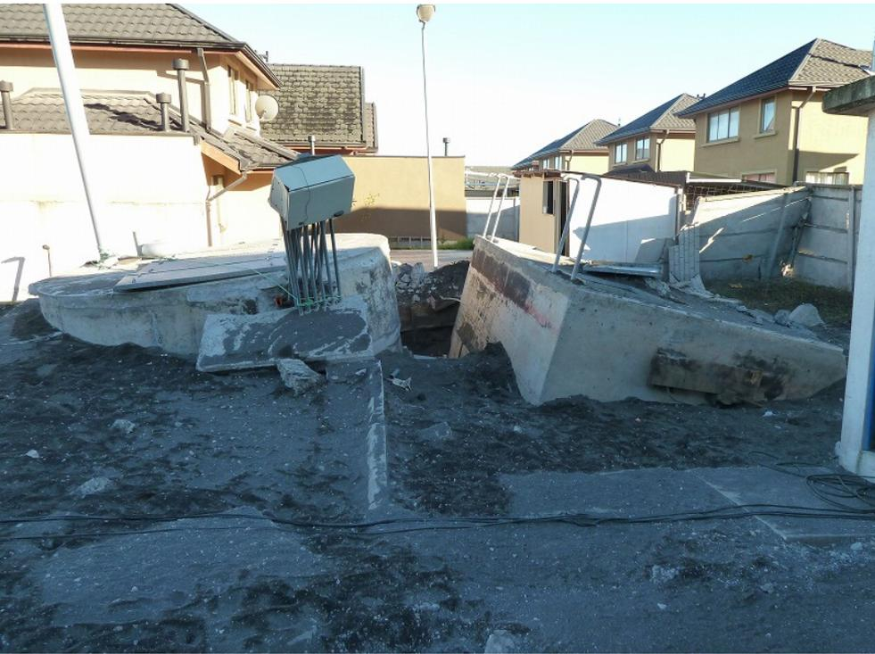
下水処理施設の液状化による浮上
