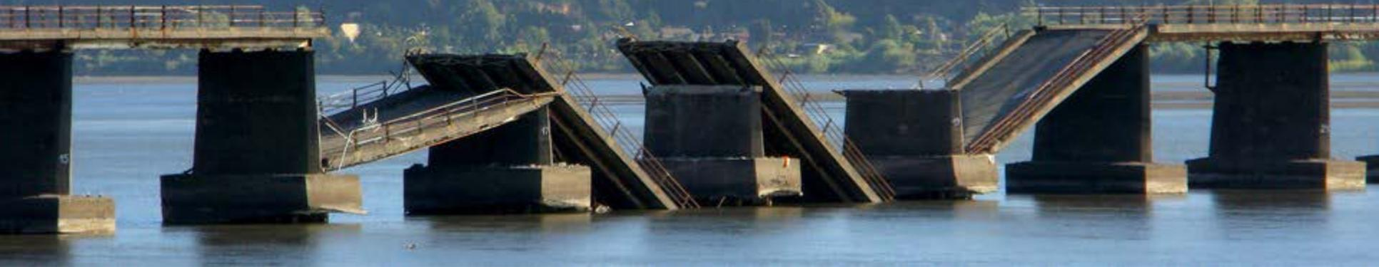
橋脚基礎部の液状化による桁の落下
