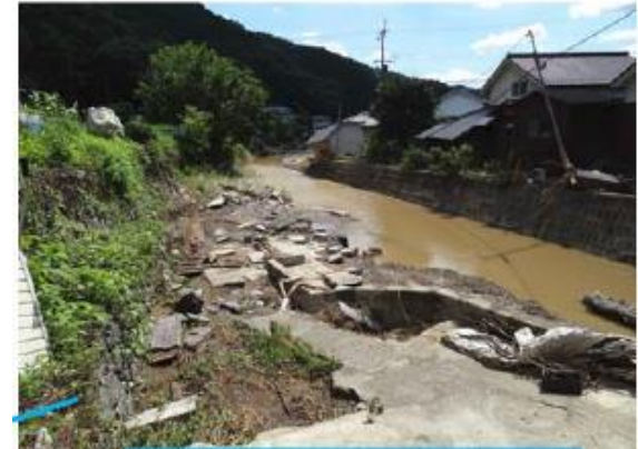
宇治市志津川 家屋流出箇所 (国土交通省近畿地方整備局資料から)
